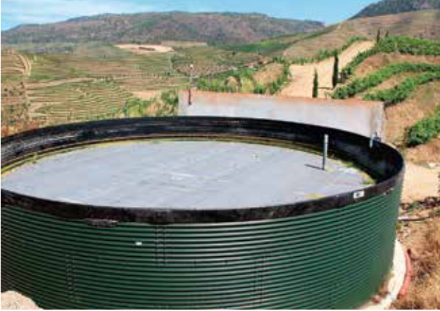
ARMAZENAMENTO DE ÁGUA
